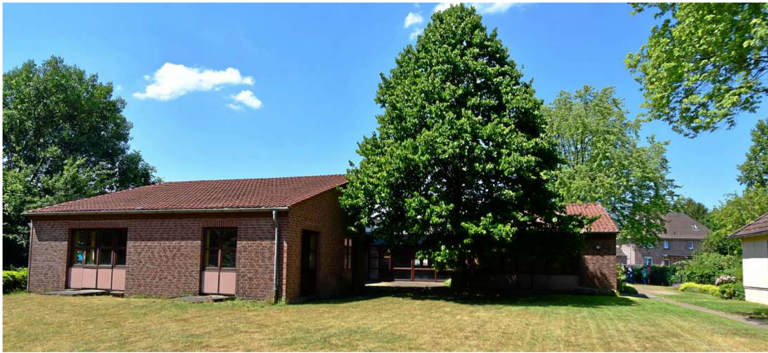
Das ehemalige Gemeindehaus der evangelischen Gemeinde Holten-Sterkrade soll abgerissen werden.
